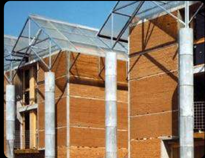
Logements modernes en pisé (L'isle-d'Abeau)
