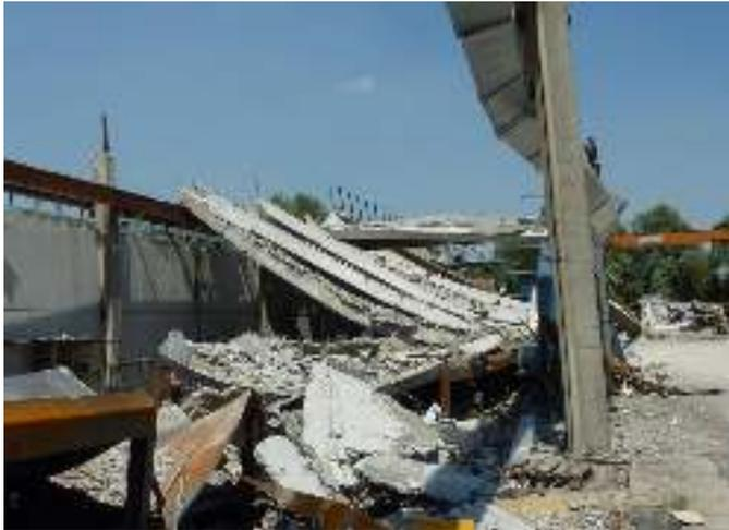
*Rupture des liaisons entre éléments verticaux et horizontaux d'une structure préfabriquée suite au séisme de Mirabello (Italie - 2012) Eléments verticaux peu endommagés*
