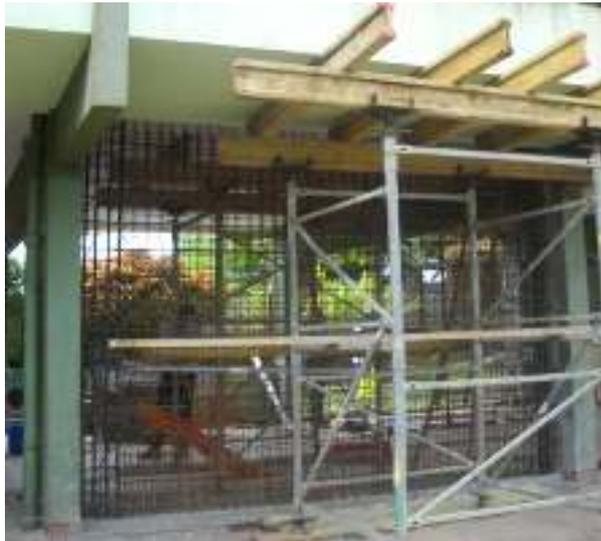
*Création d'un voile béton armé pour augmenter la résistance au séisme de l'école Roche carrées (Martinique)*
