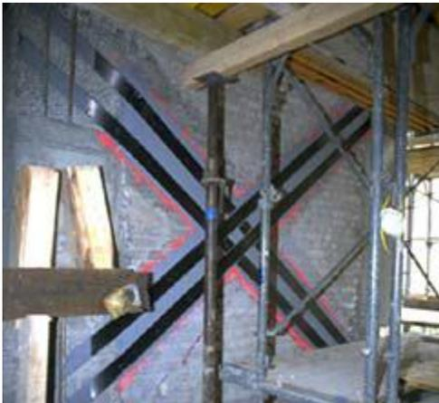
*Application de lamelles de matériau composite sur un mur en maçonnerie pour améliorer sa ductilité*
