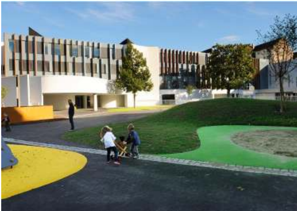
Figure : photo de la cour de récréation après projet de rénovation
