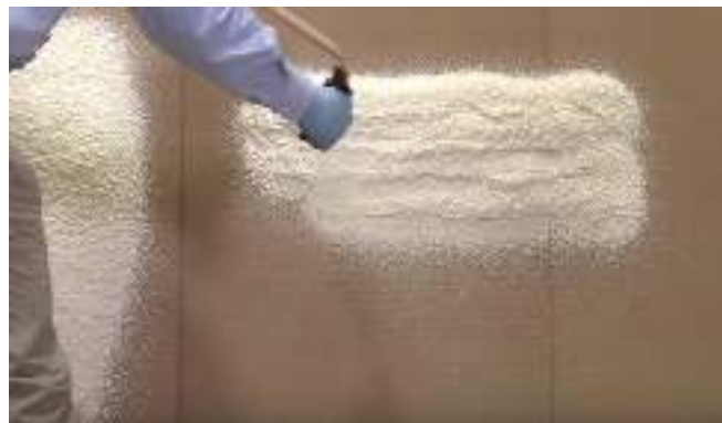
Dépose de la mousse de polyuréthane
