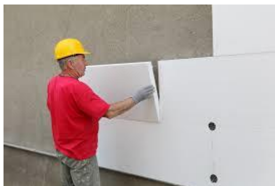
Pose de polystyrène expansé par l'extérieur
