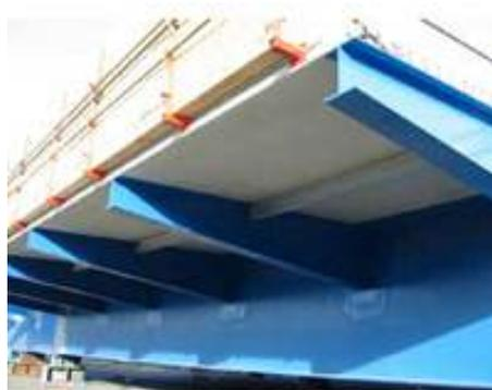
L'ouvrage retenu est de type pont mixte, c'est-à-dire constitué d'une dalle en béton armé reposant sur des poutrelles en acier et des entretoises. Les caractéristiques de ce type d'ouvrage permettent de répondre au mieux aux contraintes du site retenu pour l'implantation du pont.
