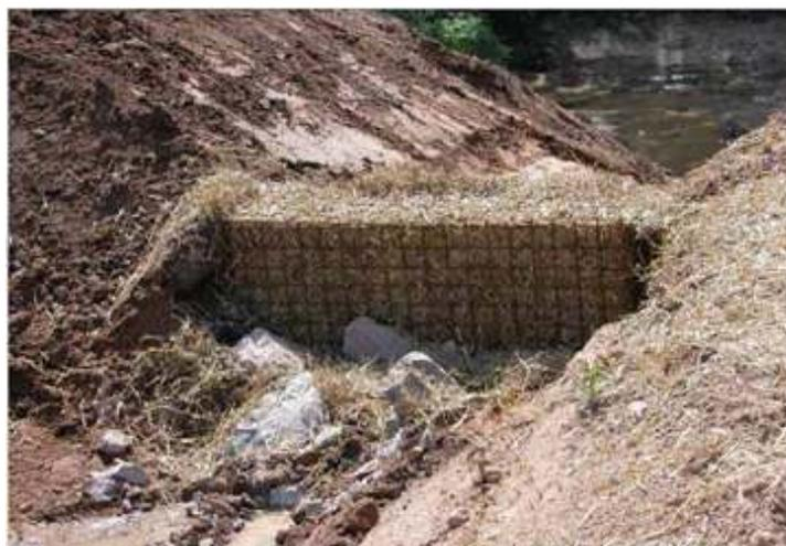
Figure 82 - Exemple d'assainissement provisoire destiné à récolter les fines en suspension dans l'eau (limitation des pollutions en phase travaux)
