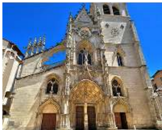
Figure 2 - Façade de l'Eglise Notre des Marais à Villefranche
