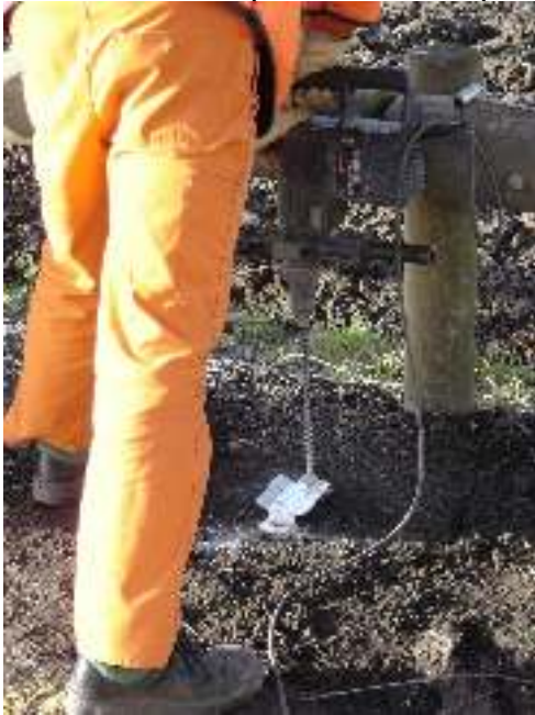
Vissage du support d'une borne départementale dans du béton
