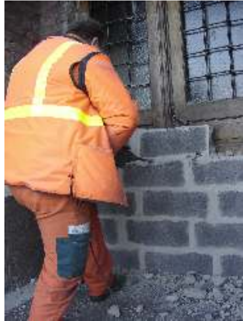
Démontage d'un mur de parpaings
