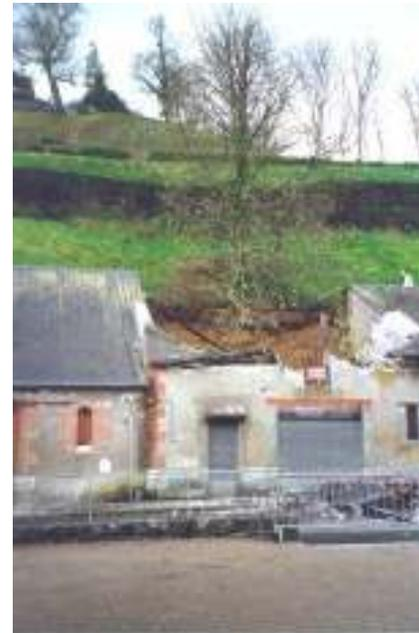
Figure 2.1. Première phase du glissement de terrain
