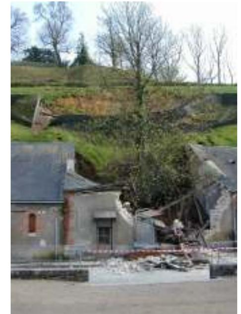
Figure 2.2. Seconde phase du glissement de terrain
