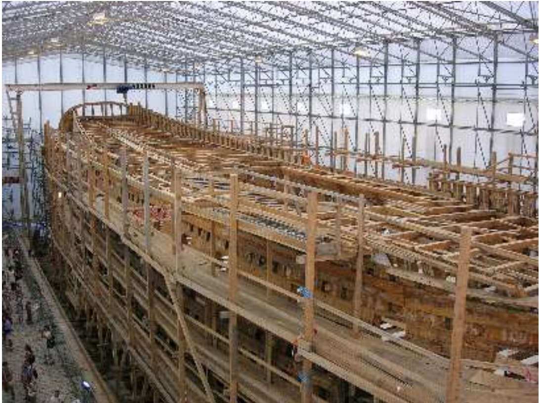
Figure 1.2: Le chantier de L'Hermione
