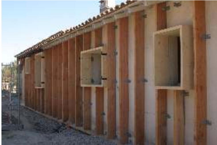
FIGURE 2.2 – Isolation extérieure des murs extérieurs
