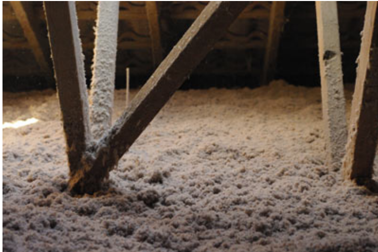
FIGURE 2.3 – Ouate de cellulose soufflée dans les combles
