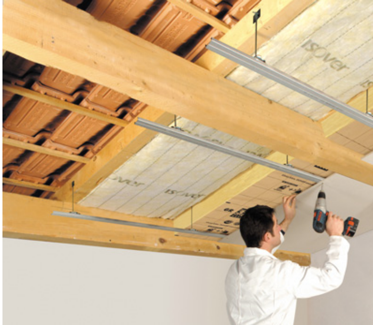
FIGURE 2.4 – Isolation de la toiture par l'intérieur
