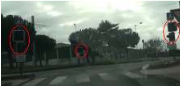
FIGURE: Les R24 sont trop proches du passage du tramway.
