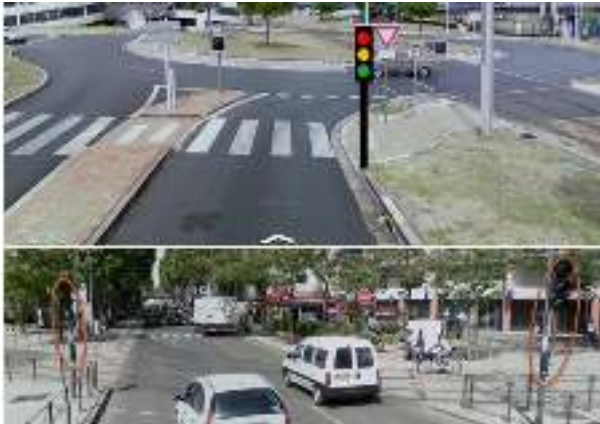
FIGURE: Installation de feux rouges en amont du giratoire.
