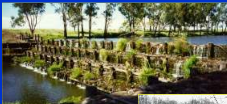
Barrages en bois (+enrochements)
