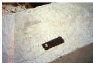
Photo n° 21 : cassure de béton frais sur un muret (photo DP)
