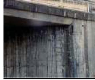
Photo n° 9 : culée et tablier touchés par l'alcali-réaction (photo DP)
