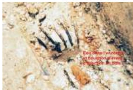
Photo n° 40 : encoche pleine d'eau d'un câble relevé (photo LRPC)
