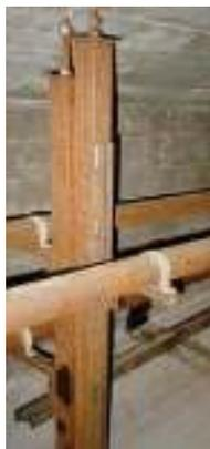
Photo n° 29 : corrosion due à la condensation (photo DP)
