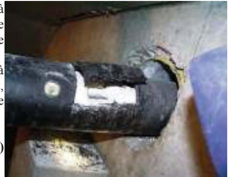
Photo n° 58 : fenêtre avec coulis blanchâtre (photo DDE de la Réunion)
