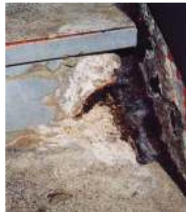
**Photo n° 5 : attaque du béton des marches d'une station de métro (photo DP)**
