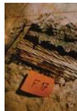
**Photo n° 56 : fenêtre montrant un conduit non injecté avec une corrosion des torons (photo LRPC)**
