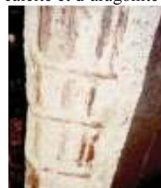
Photo n° 7 : attaque du béton par l'eau de mer (photo DP)
