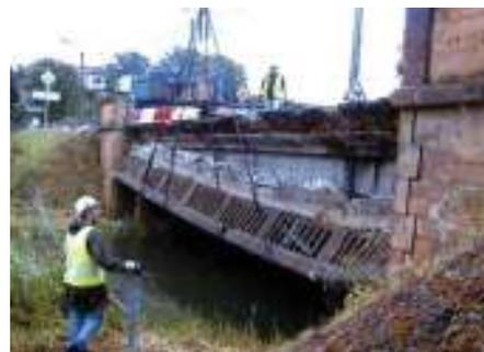
**Photo n° 37 : chute de l'encorbellement (photo DDE 54)**
