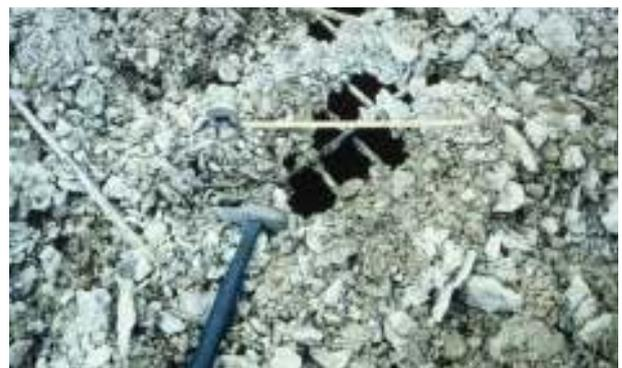
Photo n° 15 : gel du béton du hourdis du pont de La Neuville près de Reims (photo DP)
