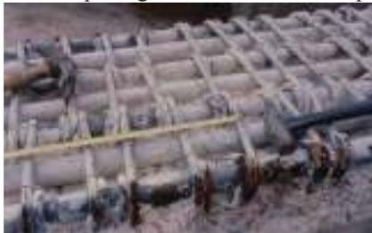
Photo n° 26 : corrosion localisée (piqûres) au pont de La Neuville (photo DP)
