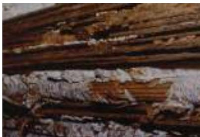
Photo n° 28 : les gaines plombées d'un VIPP (photo LRPC)
