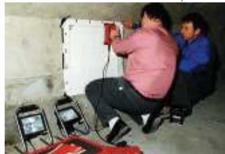
**Photo n° 50 : recherche de la position des armatures de béton armé lors des réparations du pont de Châlons-sur-Marne (photo Cerema)**
