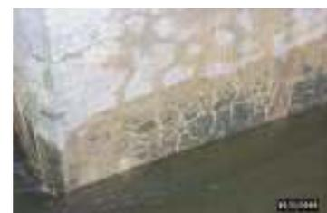
**Photo n° 12 : réaction sulfatique interne sur un fût de pile (photo DDE 44)**
