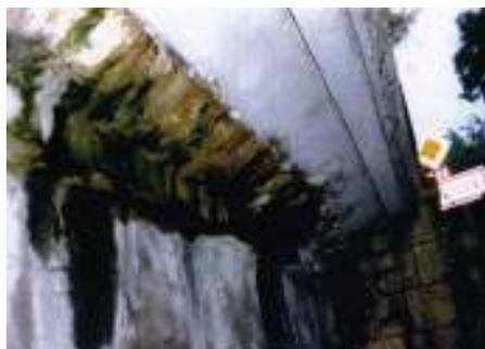
**Photo n° 36 : fissure avec passage d'eau (photo DDE 54)**
