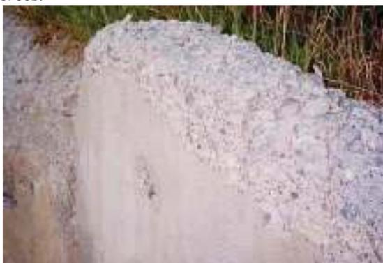
Photo n° 14 : effet du gel interne sur un mur de soutènement à Pra-Loup (photo DP)
