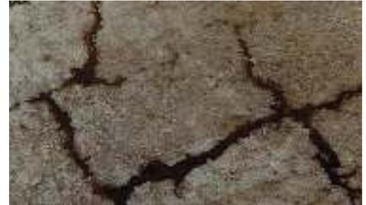
Photo n° 22 : fissuration due à des retraits thermiques à la surface d'un béton B 60 (photo DP)
