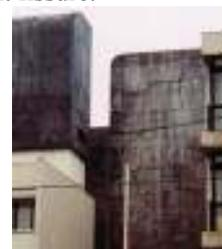
Photo n° 18 fissuration d'un mur de couleur foncée (photo DP)
