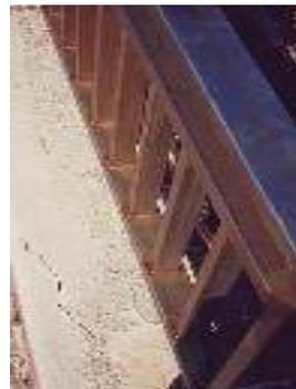
**Photo n° 31 : garde-corps en acier inoxydable près de Menton non adapté à l'air marin (photo DP)**
