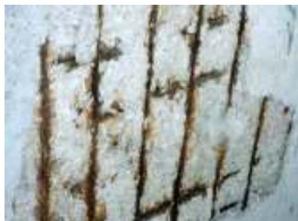
**Photo n° 35 : corrosion généralisée sur un mur de front de culée en Moselle (photo DP)**
