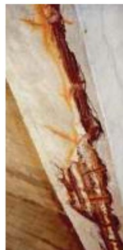
**Photo n° 34 : fracturation et corrosion avancée d'une poutre dans les Alpes-Maritimes (photo DP)**
