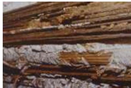
Photo n° 45 : corrosion généralisée des câbles de précontrainte d'un VIPP (Photo LRPC Strasbourg)
