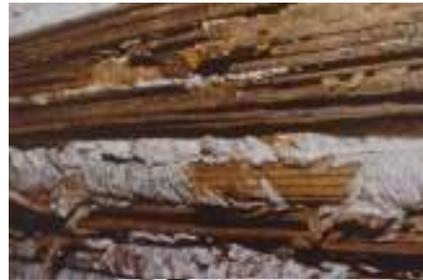
**Figure n° 45 : présence d'eau fossile dans le conduit en PEHD**
