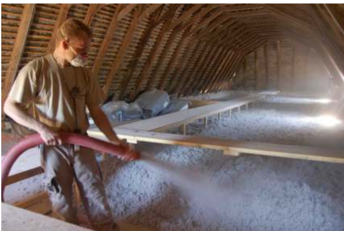
Figure: Soufflage de ouate de cellulose dans des combles
