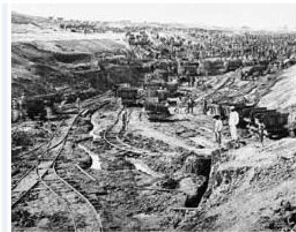
Fig. 4 : Photographie des travaux du Canal de Suez
