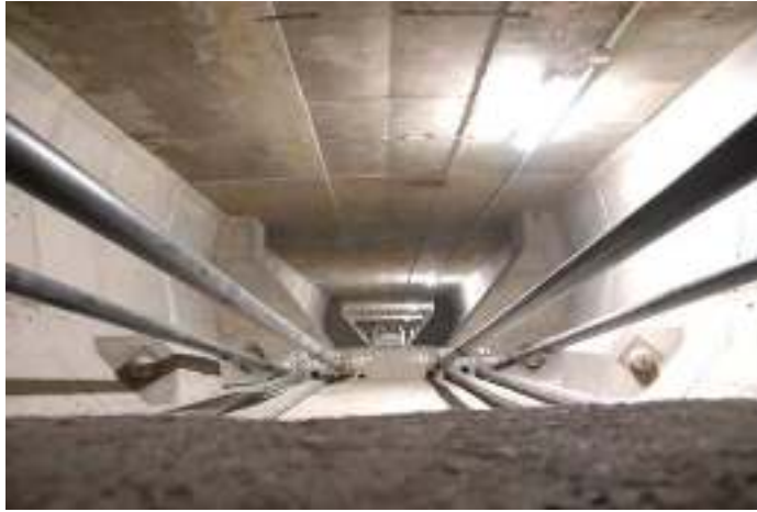
Photo n°20 : exemple de précontrainte longitudinale extérieure
