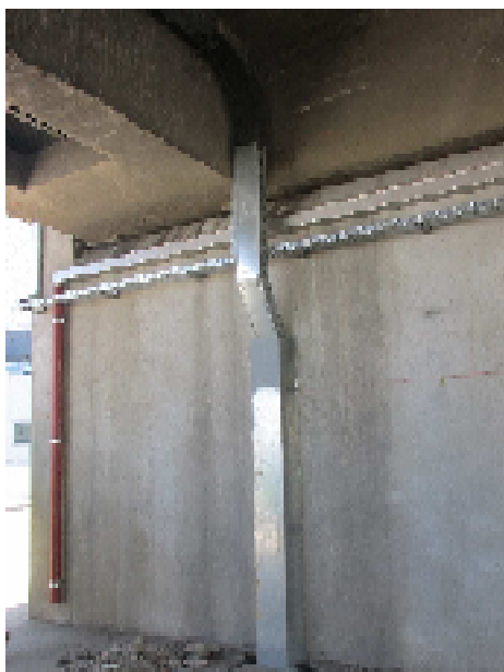
Photo n° 6: Parois en béton de la culée Sud réparée
