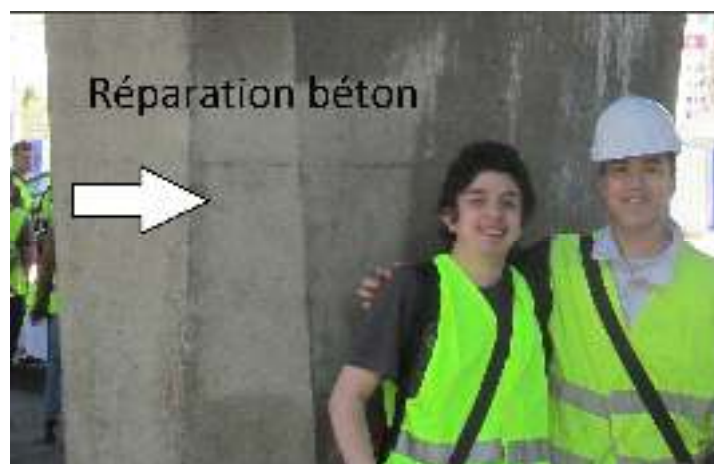
Photo n°18: réparation superficielle des piles
