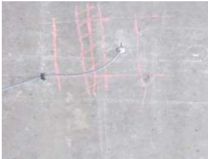
Photo n° 13 : Installation de sondes thermiques
