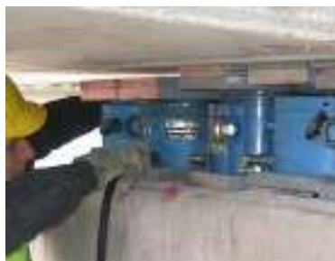
Figure 24 : Exemple de vérinage
