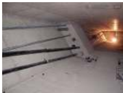
Figure 26 : Exemple de précontrainte extérieure en caisson
