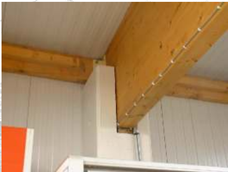
Le Bâtiment en photos: liaison poutre principale/poteau BA
