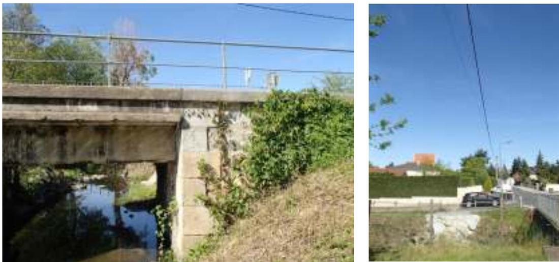
**Figure 8 : Visite du chantier du pont de la rue de la Sonde à Veauche. Mise en évidence des réseaux aériens pouvant interférer avec l'utilisation d'engins de levage**
