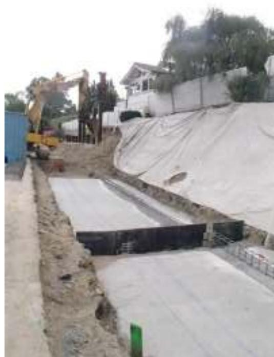
Figure 3 : Les terrassements et les bétons de propreté au 7 août – L’emplacement du mur correspond aux traits bleus
