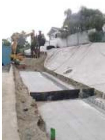
Figure 2 : Les terrassements et les bétons de propreté
