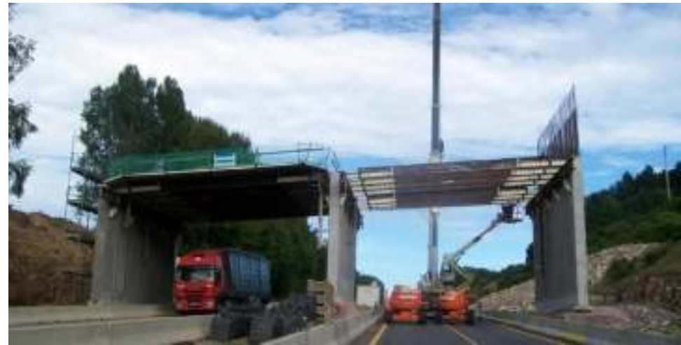
RN 57 - DÉVIATION DE PLOMBIERES-LES-BAINS : 1,5 M
