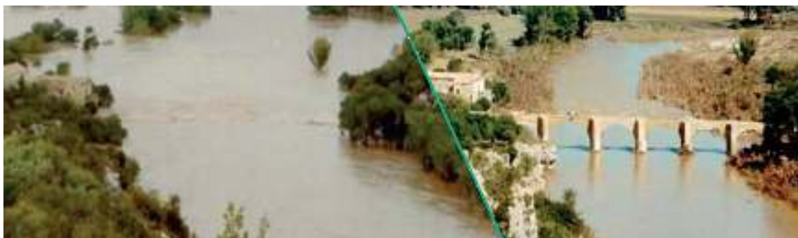
Figure 15 : Le Pont St Nicolas, pendant et après la crue.
