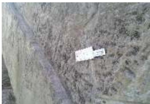
*Figure 4.1 : Règle de mesure de l'accroissement des fissures*
