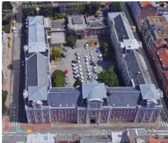
Figure 3 : Vue aérienne du bâtiment du CEREMA Nord-Picardie (site de Lille)
