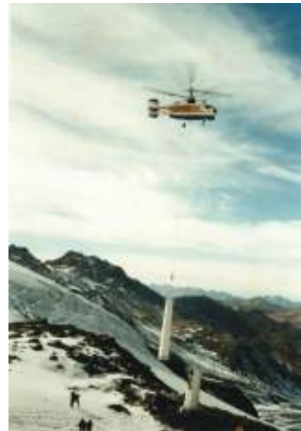
Figure 1 Montage d'un télécabine à Val Thorens (1994)
