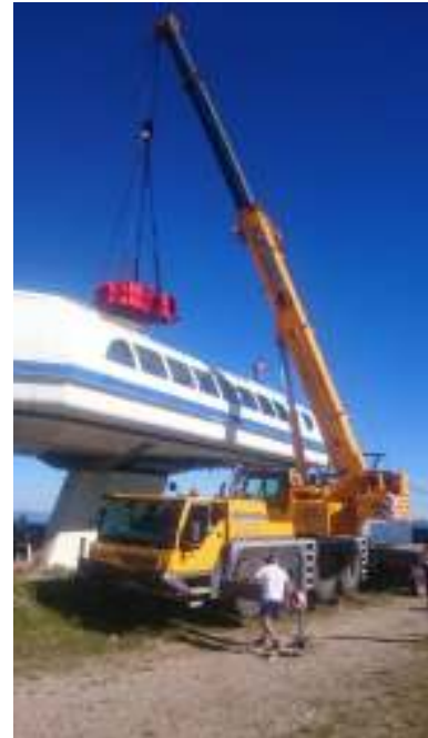
Figure 4 Levage du réducteur (Ax-les-Thermes)
