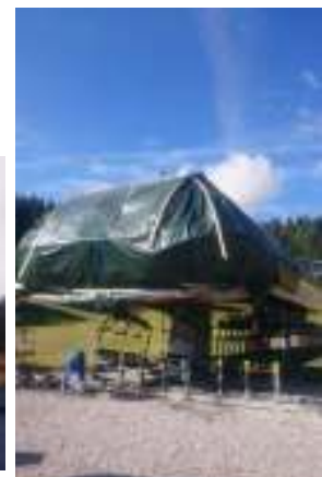
Figure 5 Aperçu de l'état de la gare depuis l'extérieur
