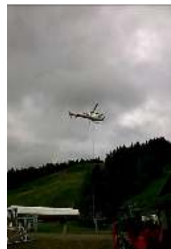
Figure 2 Hélicoptère des éléments du pylône (Les Gets)
